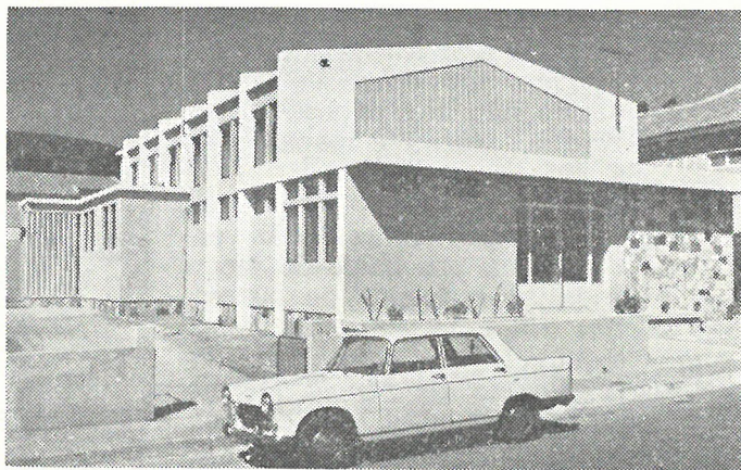
Vista exterior do Templo de Sá da Bandeira
