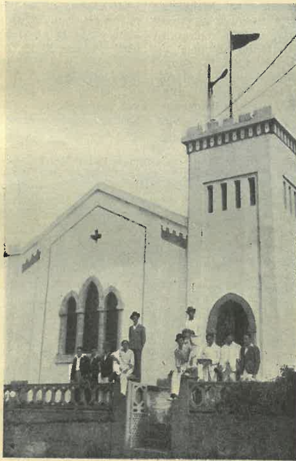
Edifício da Congregação Adventista, na Brava
