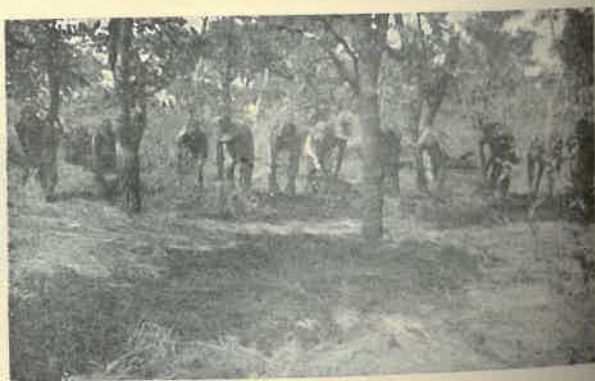
Desbravando o terreno no interior de Angola
