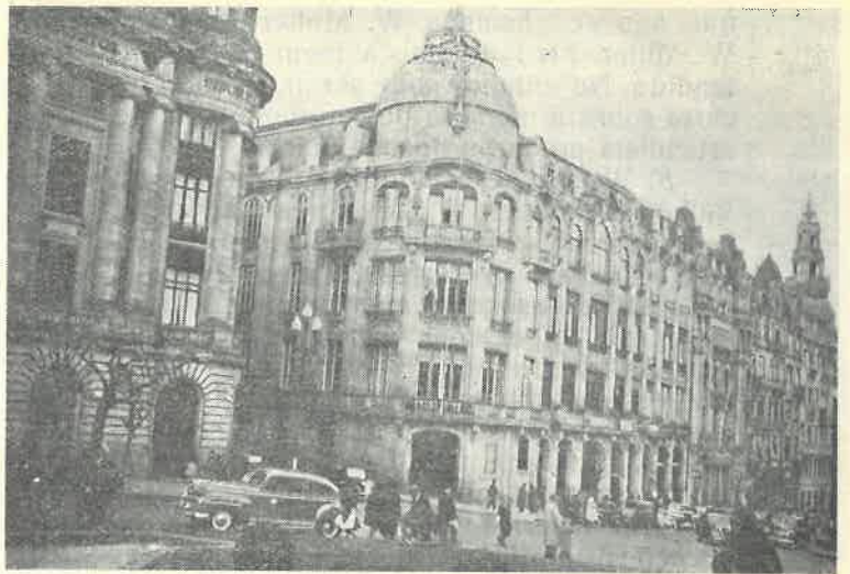
Avenida dos Aliados, Porto
