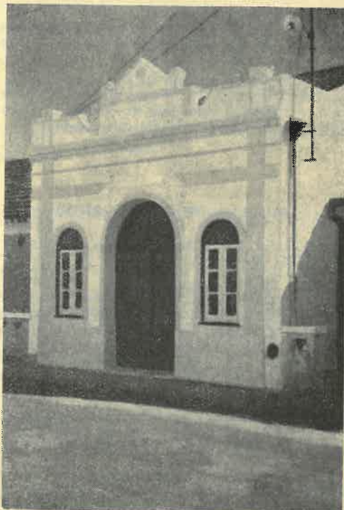
A casa de culto do Entroncamento, depois das obras de adaptação
