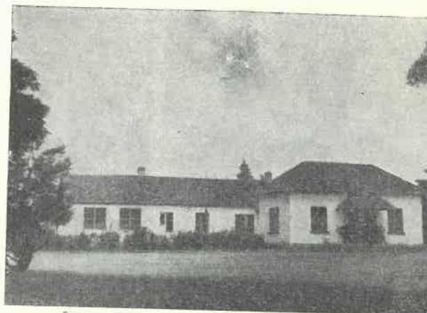
Vista frontal do Hospital do Bongo
