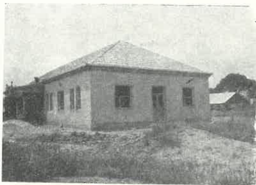
Hospital em construção na Missão do Cuale
