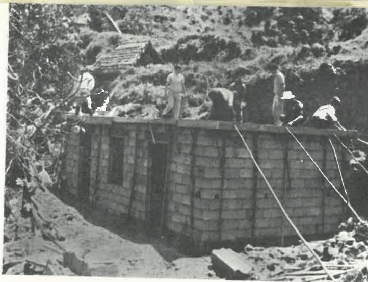
Equipas de trabalho voluntário da O.F.A.S.A. construindo casas para dar
