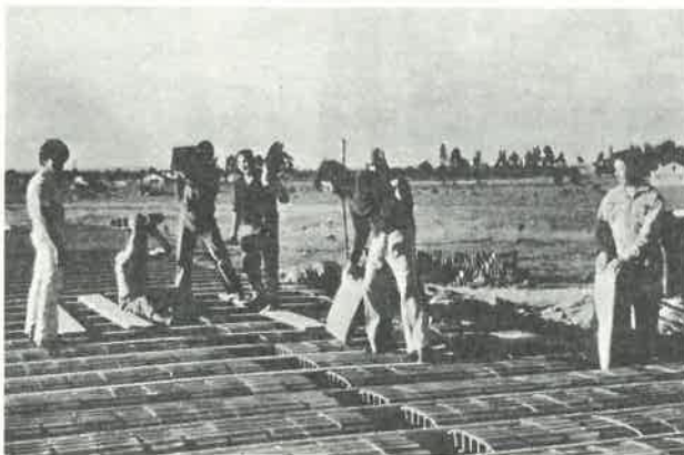
Equipa de crentes voluntários da igreja de Santarém dedicando um Domingo na construção do LAPI. Estes crentes puseram 350 vigas de cimento em dois Domingos.
