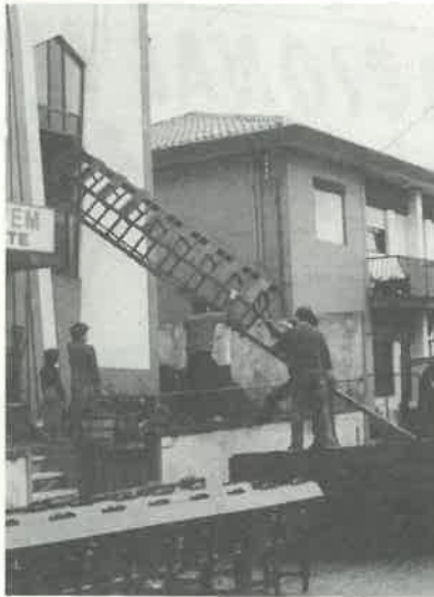
Chegou a hora de esvaziar a Igreja para começarem as obras. Um banco saindo pela janela, directo à camioneta.
