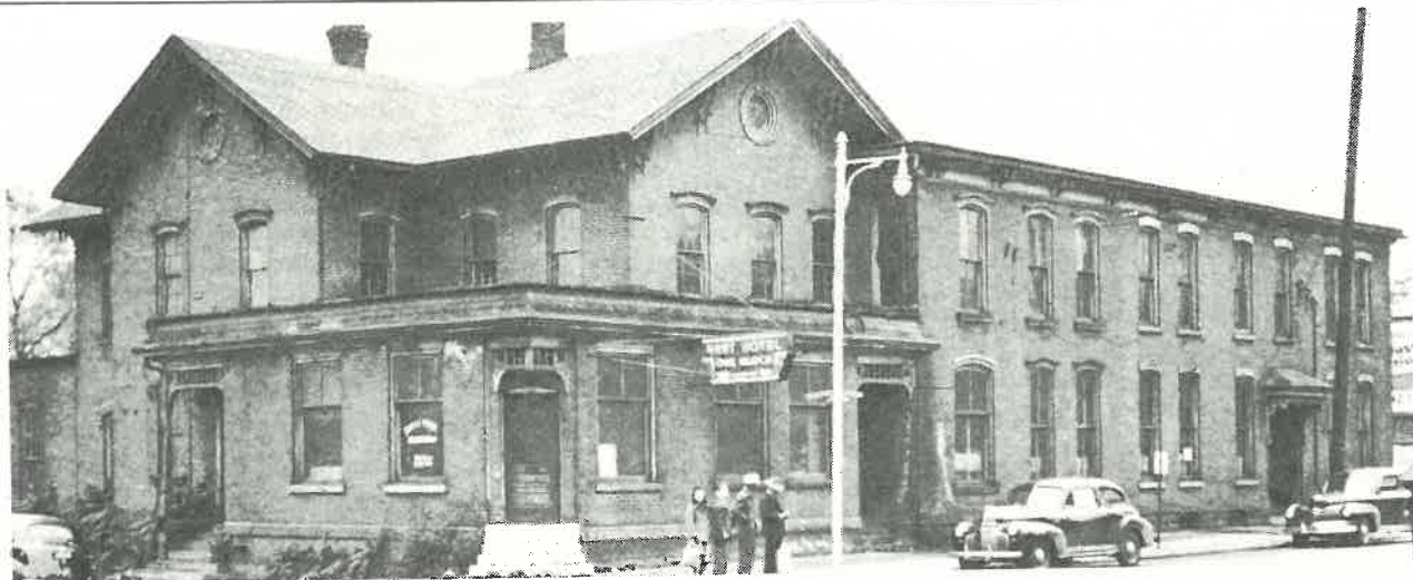
O velho edifício de Battle Creek em que estiveram instalados os primeiros escritórios da conferência Geral. Foi cenário de grandes momentos e importantes decisões. Daqui a sede foi transferida para Washington D.C.
