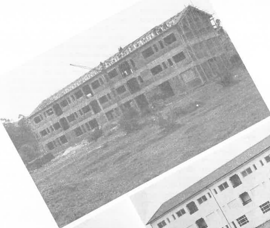
Construção do internato
