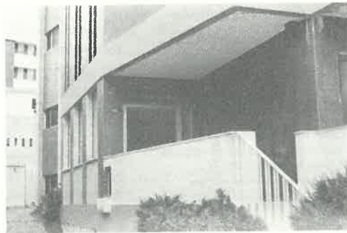
Edifício da Igreja de Coimbra onde está instalada a Escola
