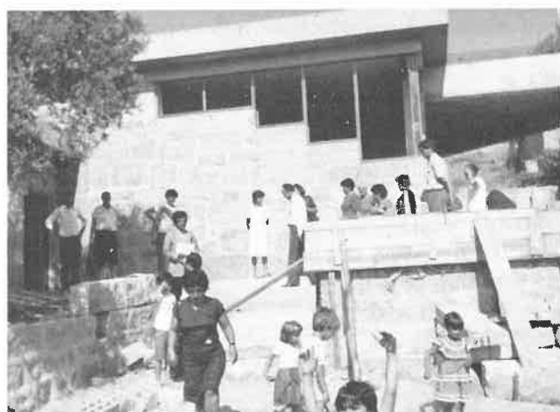
Igreja em Construção
