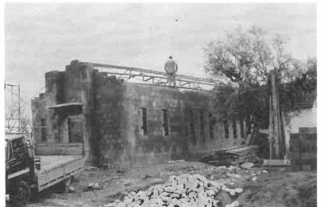
Aspecto da construção da Igreja, já numa fase mais adiantada
