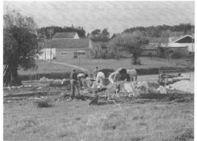
Crentes de Santarém e de S. João da Ribeira, em serviço voluntário, arrancam com a construção da 2.ª Igreja no Distrito de Santarém
