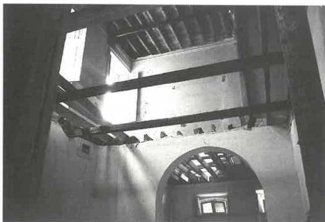
Durante as obras. O rez-do-chão visto da cave.
